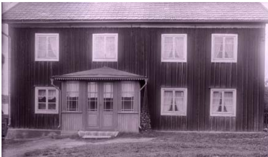
Bergsmansgården Erk Anders före 1919, eftersom fönstren byttes då.
